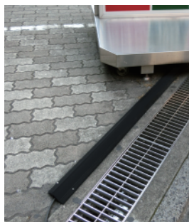
外看板のケーブル保護
